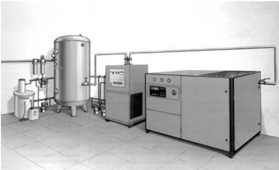
Bild 8.8 : Kompressorstation mit Schraubenkompressor, Kälte-Drucklufttrockner, Druckluftbehälter und Filtersystem
